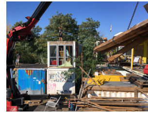
EINE DER VIELEN UMSTELLAKTIONEN, DER ABBAU IM SCHLEUSENUFER MUSSTE SEHR SCHNELL GEHEN
